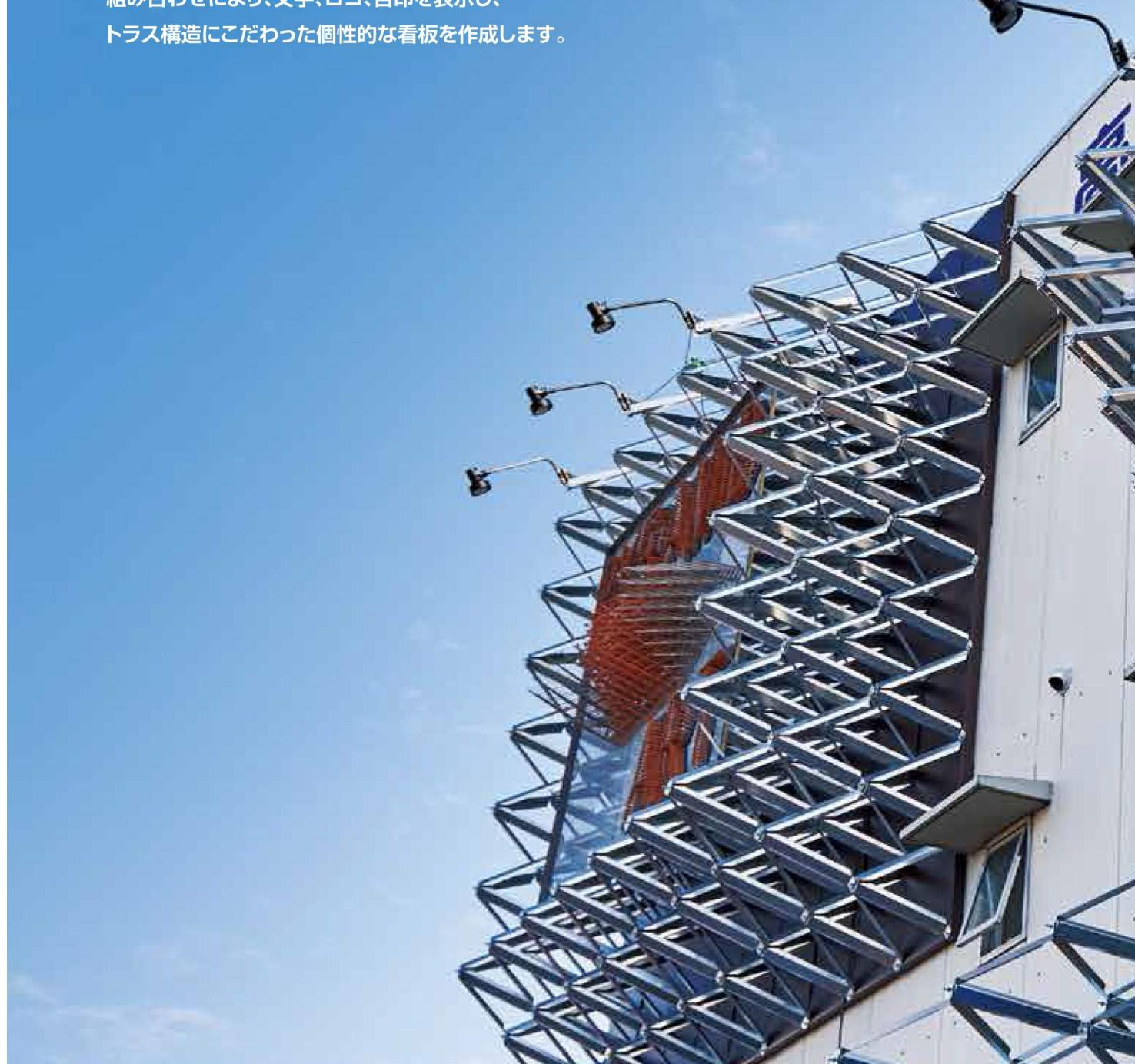
\*屋根材、外壁材のモジュールに合わせて三角錐、四角錐のモジュールを自由に設定
