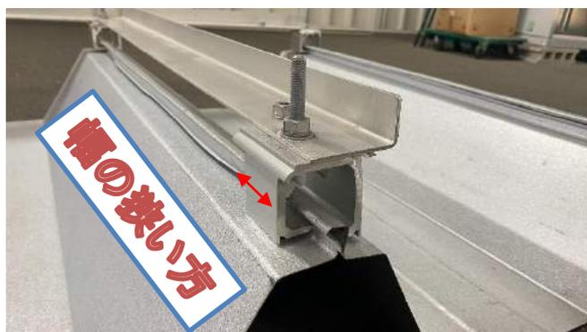
④ 掴み金物の向きは折板ハゼ小口側が開閉部の幅の狭い方にする。A,B,Cの上部のナットは外しておく
