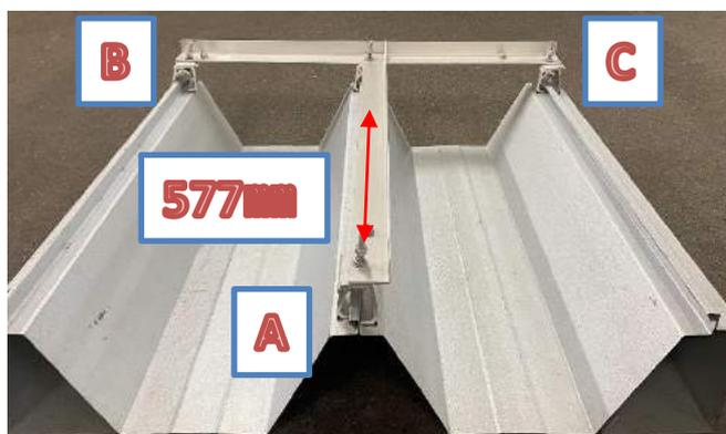
③ 先端のボルトAから577mmが支柱の芯(ボルトの位置)となるようにT字フレームを折板屋根に置き、掴み金物4個のナットをゆるめ開閉部を開き、折板ハゼ部に仮固定
