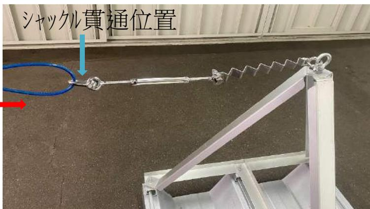
⑤ ワイヤーをターンバックルのシャックルまで**水平**に張り、シャックル貫通位置をマーキングする。
