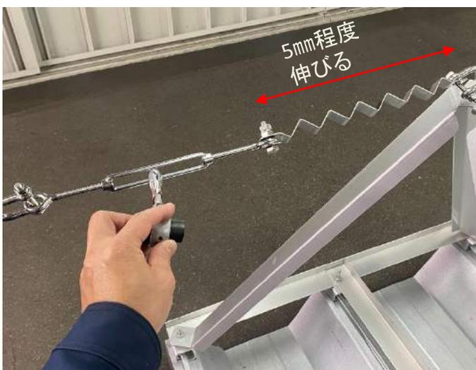
⑨ ターンバックルを回しワイヤー用ショックアブソーバーが**5mm程度**伸びるまでワイヤーを張る。
