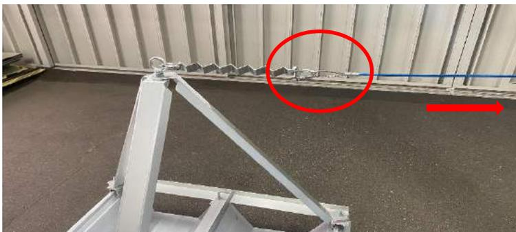
④ ③で加工したリングをワイヤー用ショックアブソーバーの**シャックル**に**固定**する。
