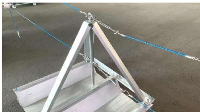
③ ワイヤーを強く張り、隣の支柱のシャックルの位置をマーキングし、マーキングから100mm程度端部側の位置でワイヤーを切断し、ワイヤー被覆をはがしアームで固定し、シャックルをプライヤー等でしっかり固定しターンバックルをシノで回しワイヤーを張る
