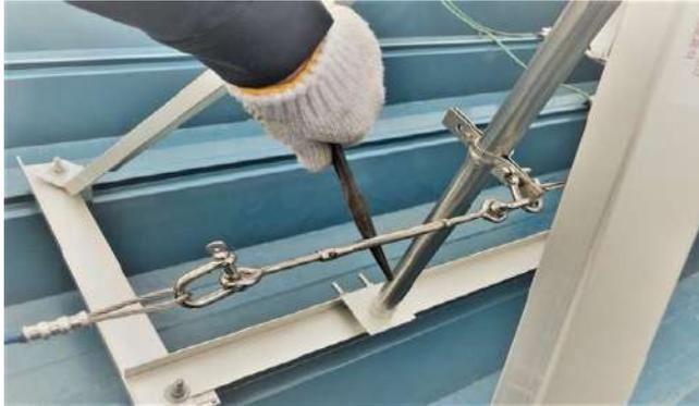
⑦ 各所シャックルをプライヤー等でしっかり固定し、ターンバックをシノで回し、ワイヤーを張る
