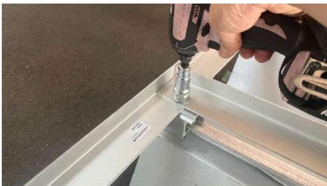
④ エのナットを17mmのビットで固定し、ア、イ、ウも同様にナットを固定する
