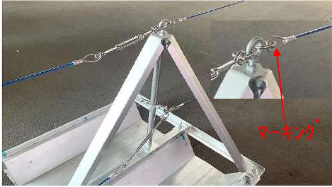
⑥ ワイヤーを強く張り、隣の支柱のシャックルの位置に合わせた位置をマーキングし、マーキングから100mm程度端部側の位置でワイヤーを切断し、ワイヤー被覆をはがしアームで固定
